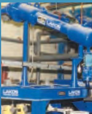
▶ El agua arenosa de río es pre-filtrada con un Desarenador LAKOS para proteger al equipo de ultrafiltrado contra excesivas rutinas de mantenimiento, antes de que el agua llegue a los pozos de inyección de alta presión.
