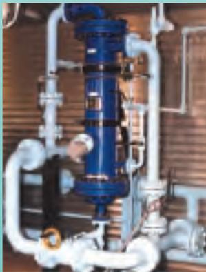
▶ Un sitio de inundación por inyección de agua depende de un Desarenador LAKOS para alargar la vida de su hidrociclón de separación aceite-agua, al remover las partículas abrasivas. Este sistema LAKOS 740 psi (51 bar) reemplazó a un filtro de bolsa, brindando mayor eficiencia, menor pérdida de presión y menor exigencias de mantenimiento.
