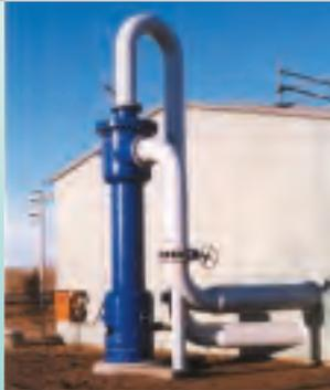
▶ En filtración primaria, un Desarenador LAKOS evita que la arena y el limo de agua de río ingresen al sistema de tuberías de una planta, reduciendo así las tareas de mantenimiento y la acumulación de suciedad en el sistema en general.
